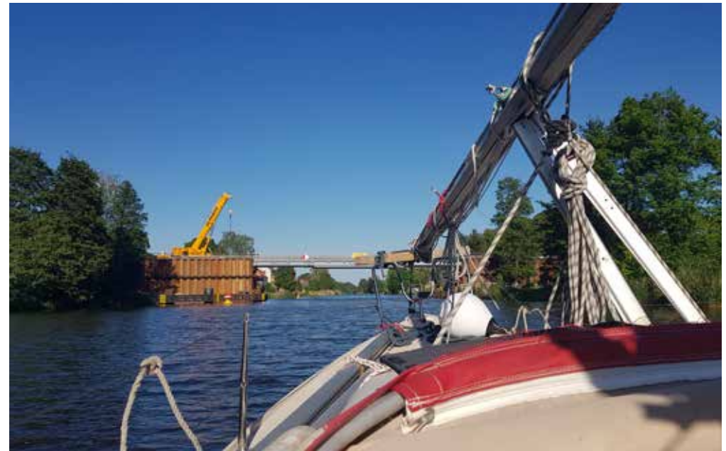
Brückenbaustelle in Oderberg - Wir nutzen die Freigabe der Wasserstraße
