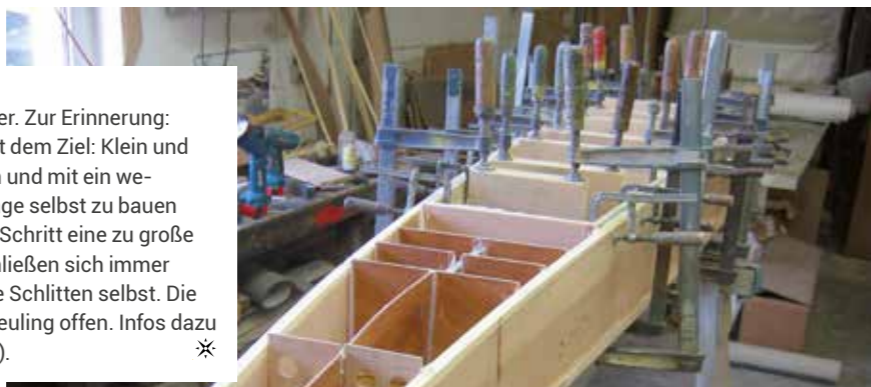
Bergner in Trappenkamp ist eine der deutschen Werften, die DN-Schlitten fertigt
